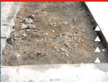
Ausstemmen des Altbeton
