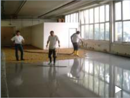
Verguss mit einem mineralisch-kunststoffgebundenen System, Aufbringen der Nutzschicht
