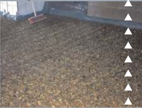
Bewehrung und Kiesdecklage
