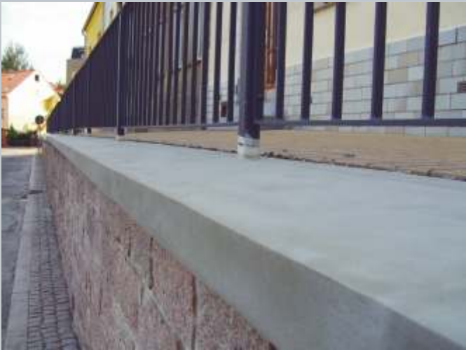
Betonsanierung, Abdichtung einer Stützwand
