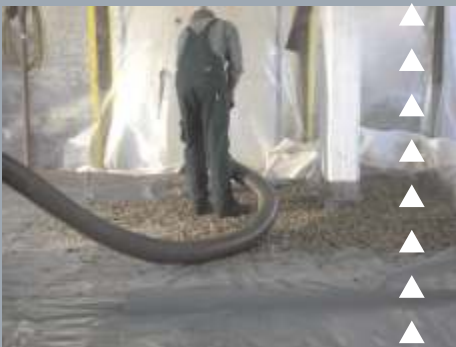
Einbringen des Kiesel, 1. Lage
