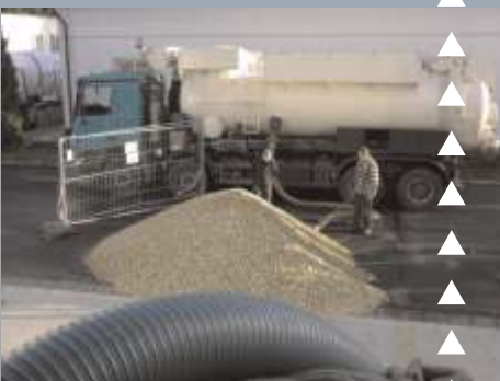
Ansaugen der Kiesfüllung mit Spezialfahrzeug,
