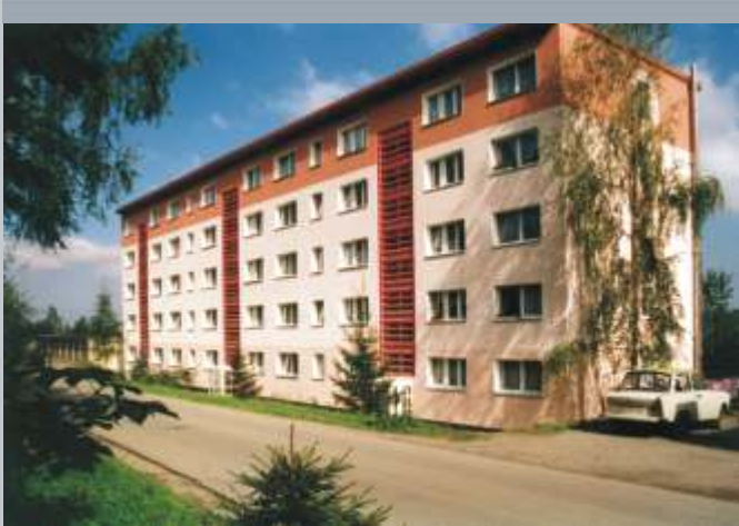
Balkonsanierung im Wohnungsbau
